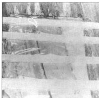
Figura 6-17 Cubra las viguetas con un plástico para impedir su encolado.
