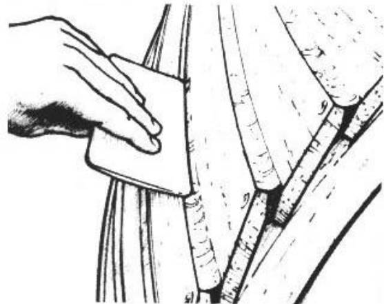
Figura 6-9 Rellene la costura impregnada con epoxi espesado.
