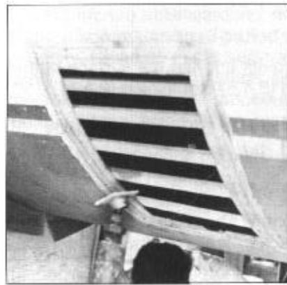
Figura 6-16 Bisele los bordes y fije unas viguetas provisionales detrás del agujero.
