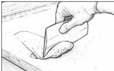
Figura 22 Aplique la mezcla de enmasillado para llenar todos los huecos, y alise para dar la forma deseada.
